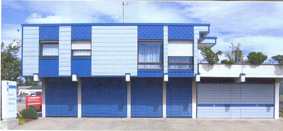
Diagonal trifft horizontal: Unterschiedliche Deckbreiten können durch Eigenanfertigung problemlos realisiert werden. Eine Computeranimation unterstützt die Planungsphase
